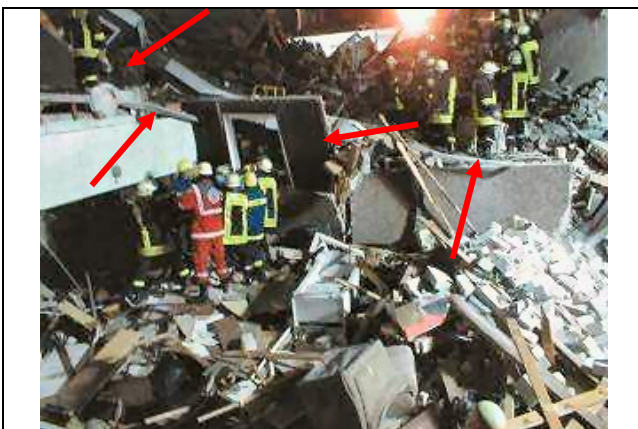
Einsatzkräfte bei einem Hauseinsturz. Gefahren durch Absturz und herabfallende Teile (Einsturz). Mit freundlicher Genehmigung: Bundesanstalt Technisches Hilfswerk, Bonn aus: Präsentation zur Basisausbildung, LA 9.4.1
